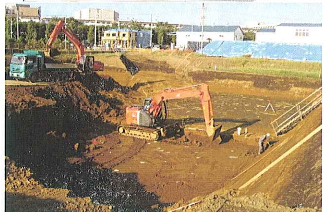
《調整池掘削工事 H23. 9. 28 現在》
